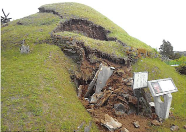
図4 【被災後】釜尾古墳（熊本市）
