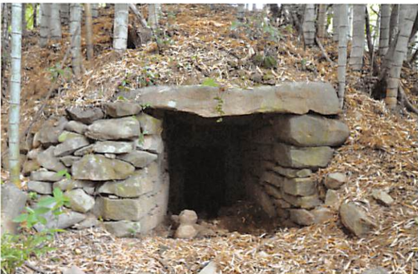
図5 〈被災前〉二軒小屋古墳（熊本市）
